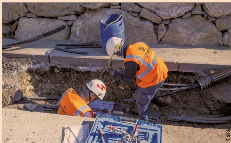
Enedis s'engage aussi à raccourcir les délais de réalisation de ses travaux sur la chaussée et sur les trottoirs.
